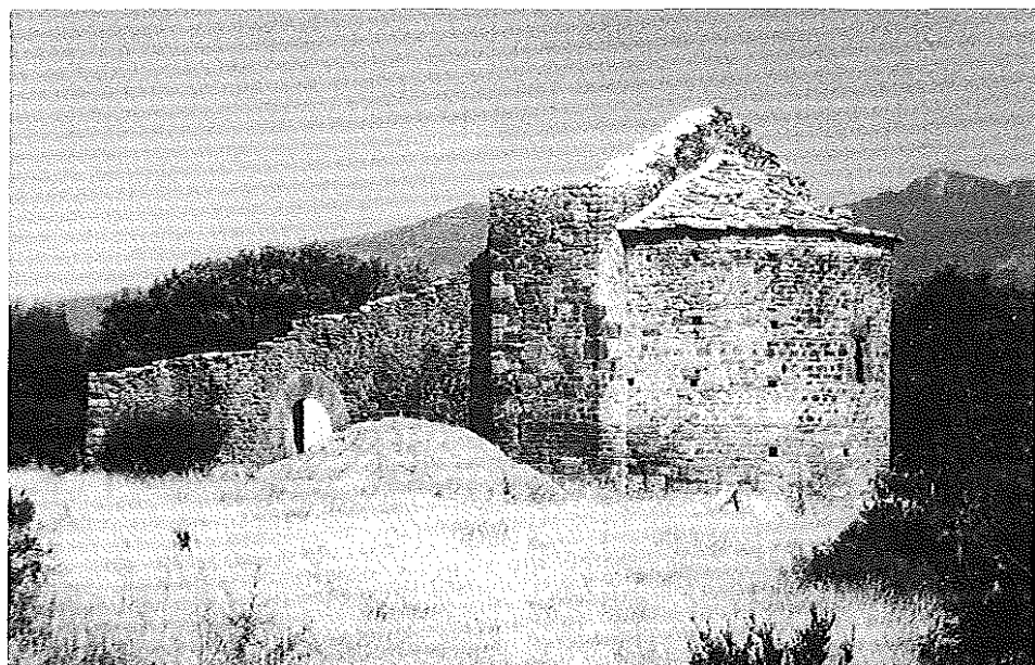
Fig. 9. Vista de la ermita de San Juan Bautista de Ruesta después de la agresiva intervención ejecutada en abril de 2001.
