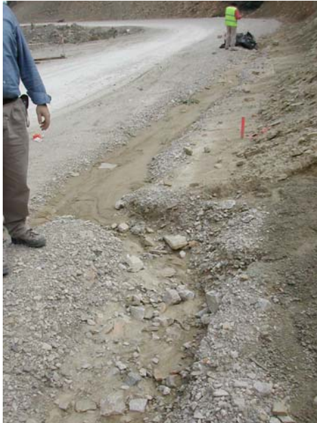
Figura 17. Fotografía de la izquierda donde se aprecia el movimiento y su influencia en la cuneta de pie. Fotografía de la derecha donde se aprecia la dimensión mayor de la grieta de cabecera.
