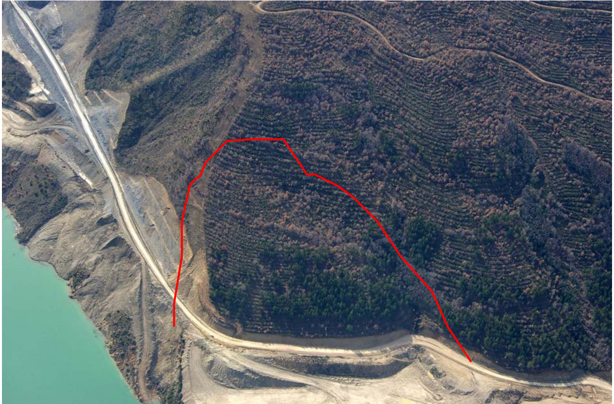
Figura 16. Fotografía de la grieta extraída de la pagina web www.yesano.com
