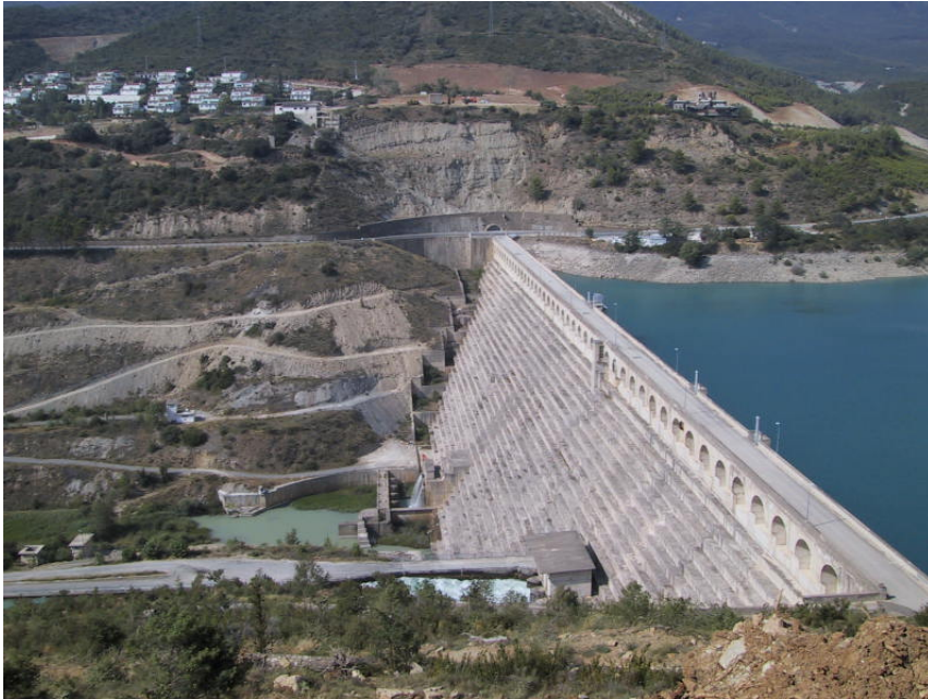
Figura 1. Aspecto de la presa en la actualidad.
