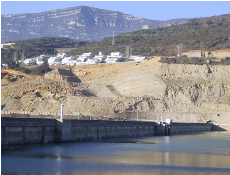
Figura 11.- Fotografía del estribo derecho de febrero de 2004 durante los trabajos de excavación.
