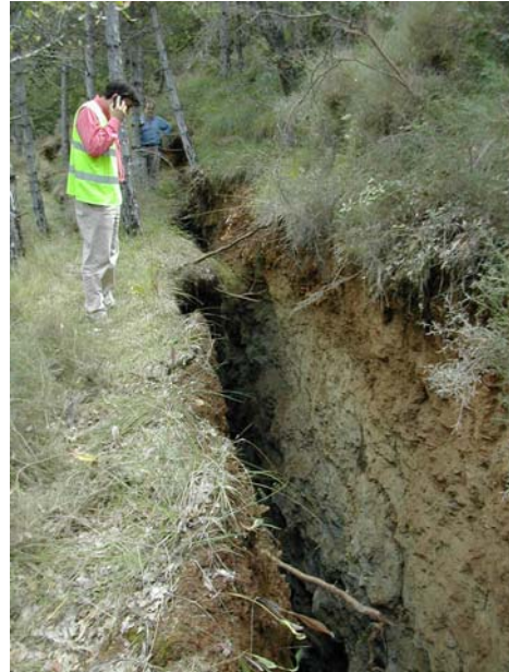
Figura 17. Fotografía de la izquierda donde se aprecia el movimiento y su influencia en la cuneta de pie. Fotografía de la derecha donde se aprecia la dimensión mayor de la grieta de cabecera.
