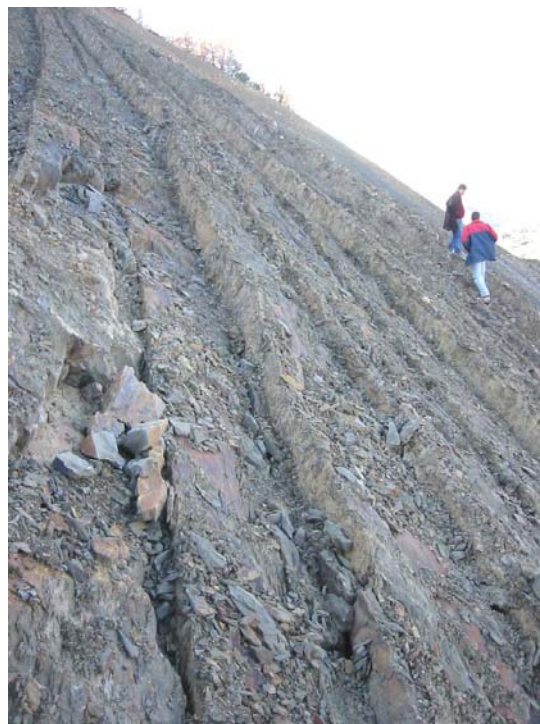
Figura 7.- Movimiento Flexural toppling en el estribo izquierdo
