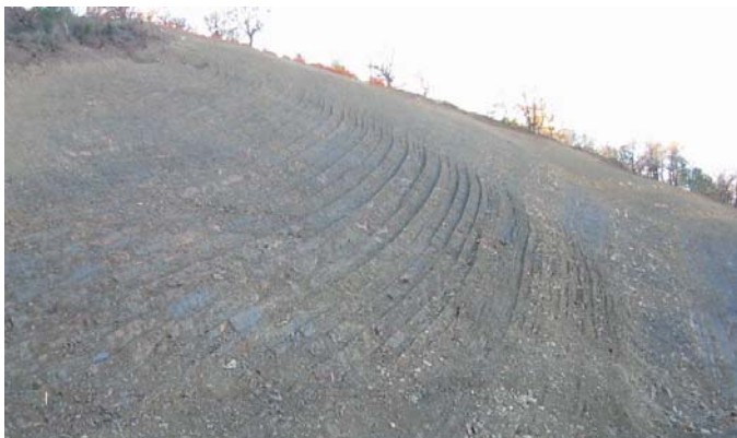
Figura 7.- Movimiento Flexural toppling en el estribo izquierdo
